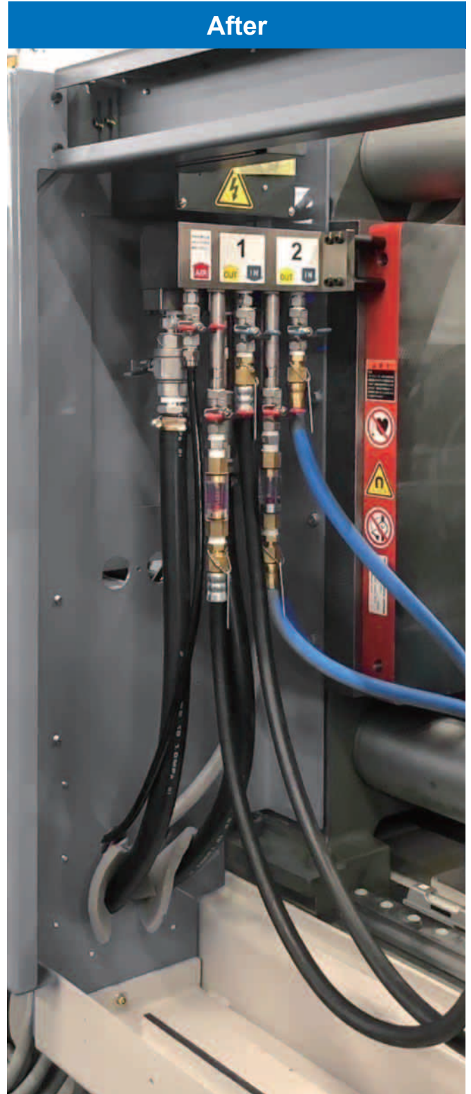
安全扉内取付ボールバルブ式へ
