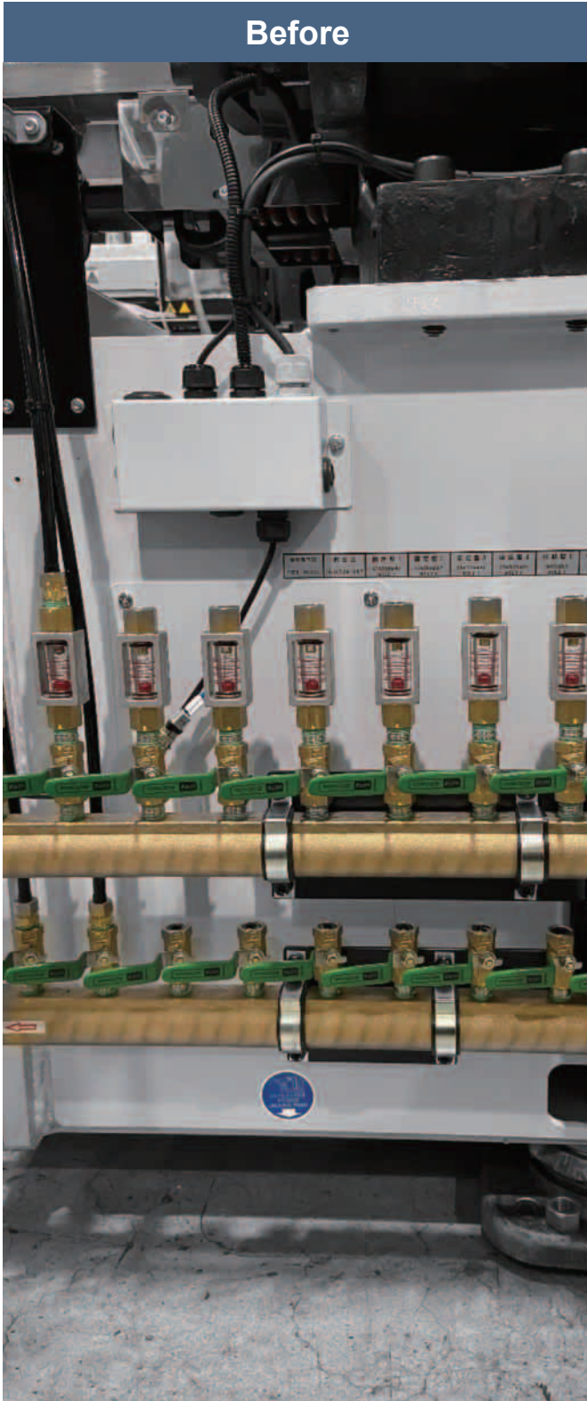
成形機マシンベットに水平配管
